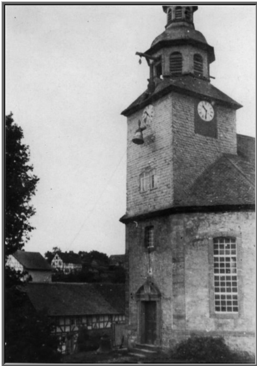
Das Bild von 1950 zeigt den Austausch der aus dem Jahr 1589 stammenden Glocke
