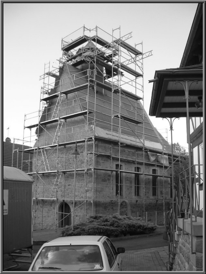
Die Kirche ist eingerüstet - 2003
